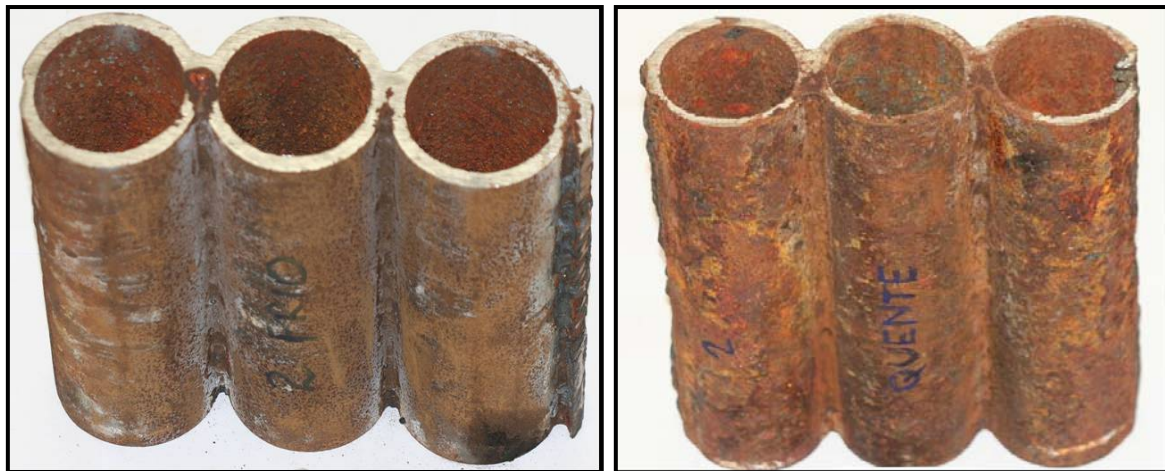
Figura 2. Tubos retirados da parte trincada de uma coifa, com a superfície que ficava em contato com o ar externo à esquerda e com os gases quentes à direita, indicando a severidade do processo corrosivo nas superfícies quentes (que formam a parte interna da coifa mostrada na Figura 1).
